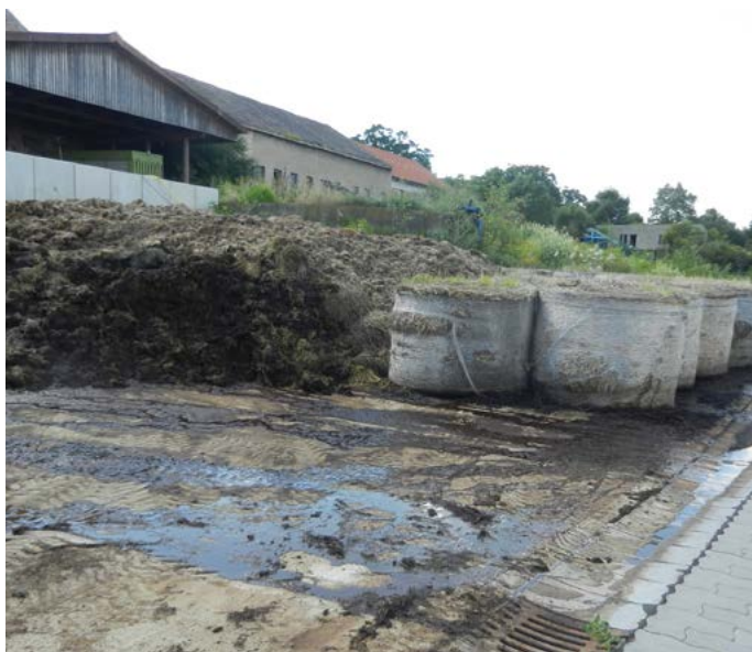
Rys. 5.2. Płyta obornikowa z wychwytem wód gnojowych, zdj. M. Krysztoforski
