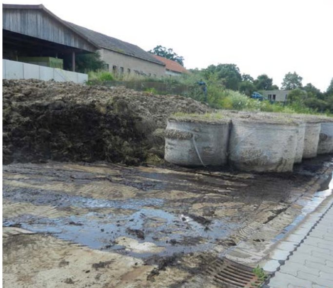
Rys. 3.3. Płyta obornikowa z kanałem wychwytyjącym wody gnojowe. Doskonałe wykorzystanie rzeźby terenu: obornik jest zrzucany na płytę prosto z obory położonej wyżej (gospodarstwo Bauerngut Templin & Mitarbeiter, Brandenburgia)
