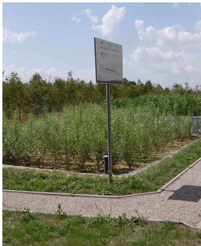
Rys. 4.5. Hybrydowa hydrofitowa oczyszczalnia ścieków dla zespołu szkół w Poizdowie z miskantem olbrzymim i wierzbą wiciową. Źródło: FDPA
