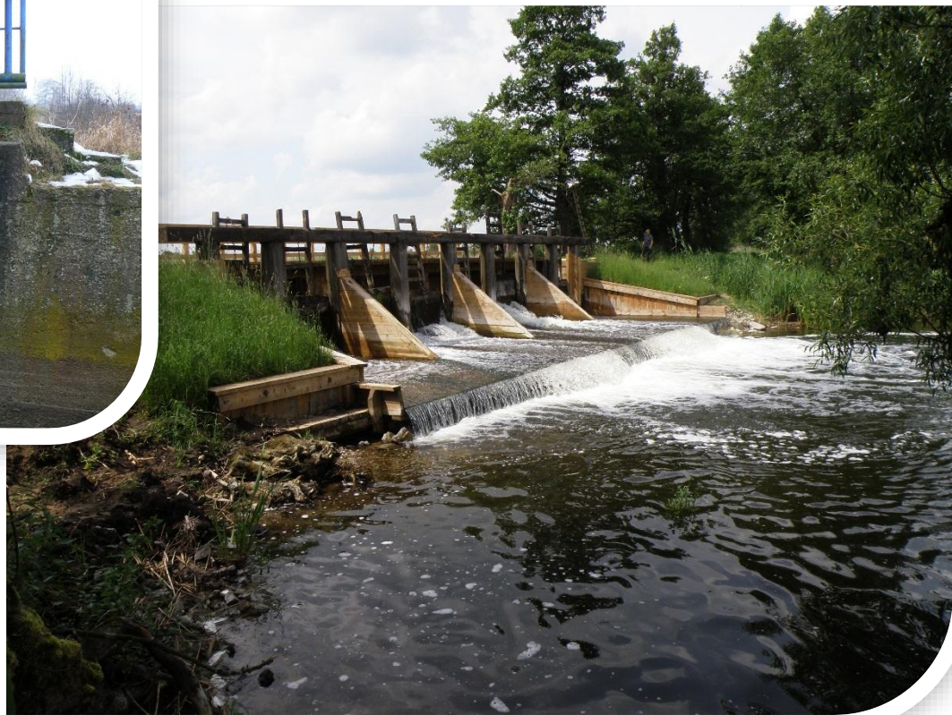
Jaz drewniany wieloprzęsłowy na rzece Jegrznia (dopływ Biebrzy), Fot. Z. Kowalewski
