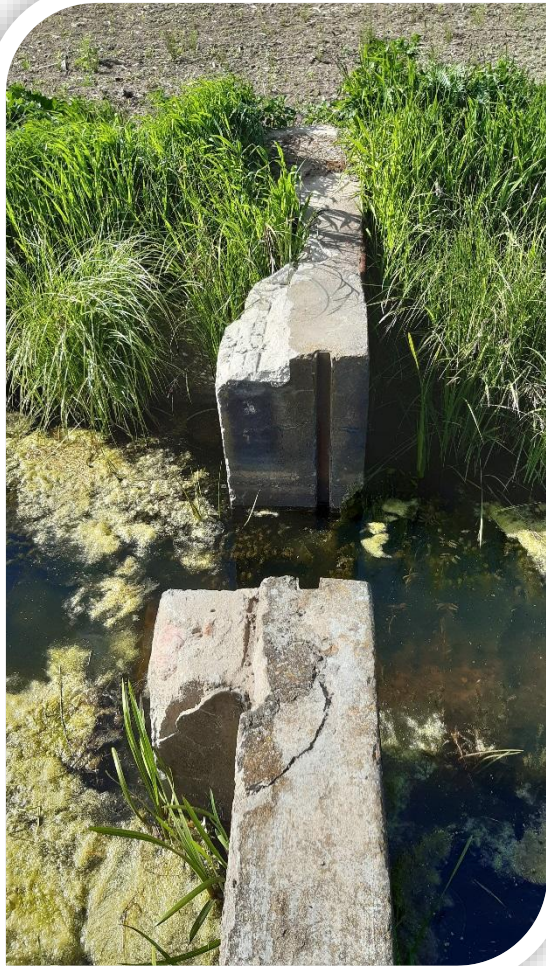
Zastawka szandorowa na rowie melioracyjnym - obiekt nawodnień podsiąkowych Troszyn, Fot. B. Kierasiński
