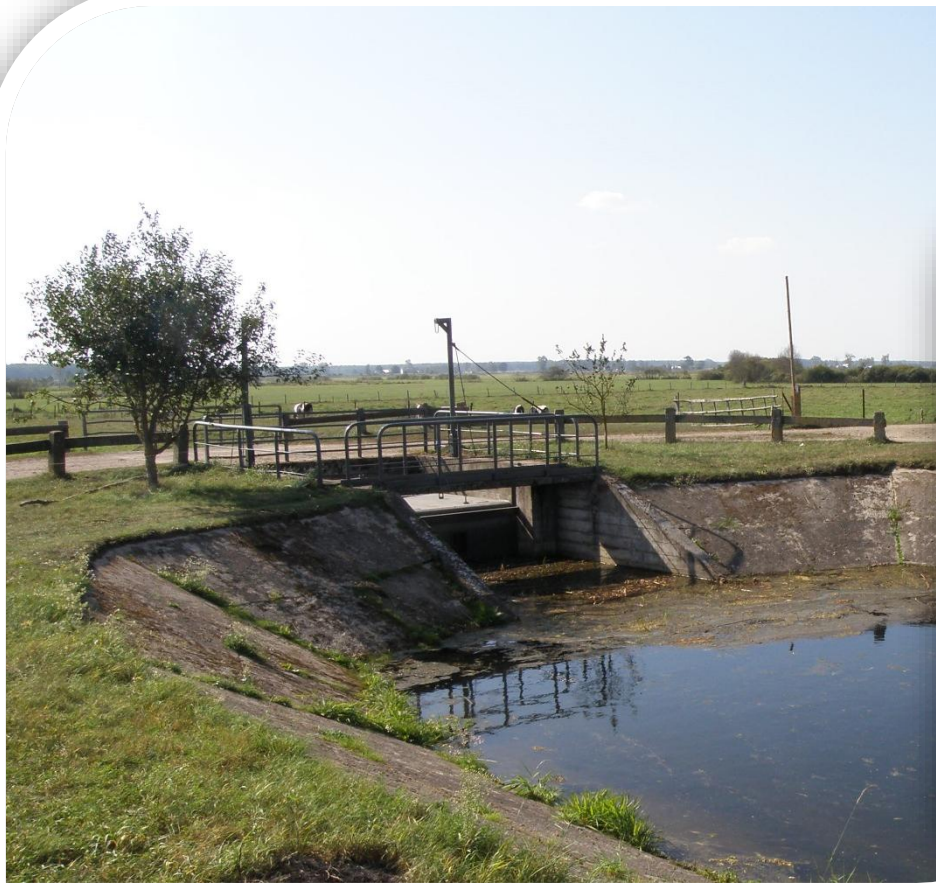
Jaz z zamknięciem sektorowym na Kanale Kuwaskim, Fot. Z. Kowalewski
