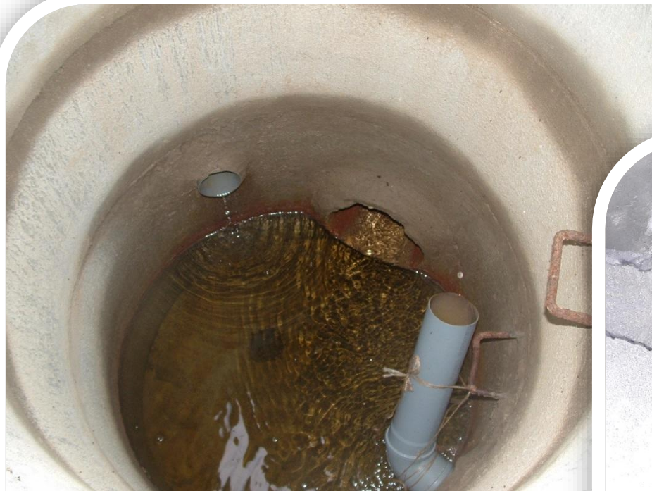
Kolanko i rura kanalizacyjna zamontowana na wylocie do studzienki drenarskiej - okolice Suwałk, Fot. W. Mioduszewski
