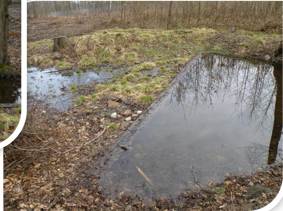
Próg kamienno-drewniany tworzący tzw. małą retencję leśną, Fot. B. Kierasinski
