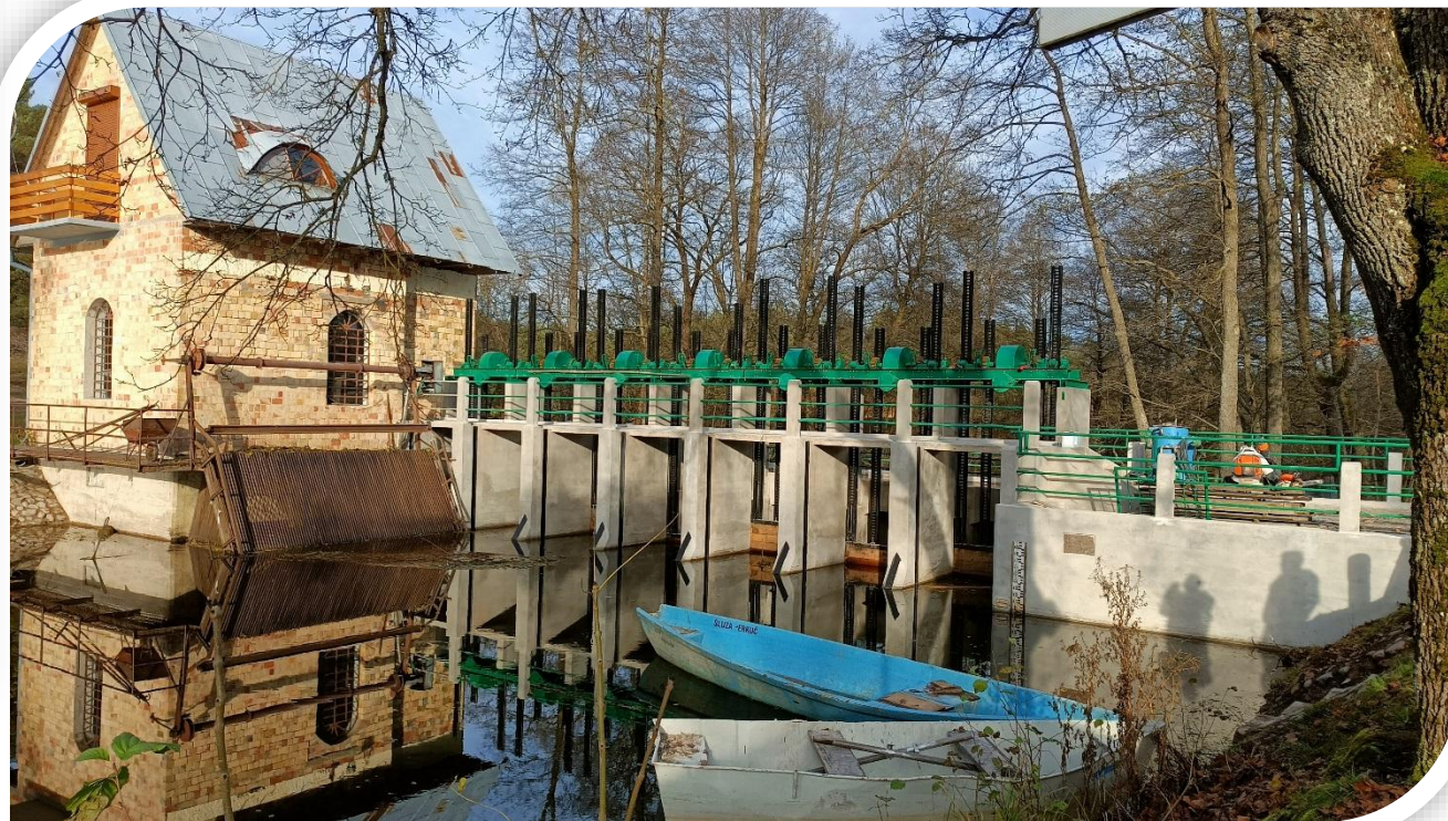
Jaz wieloprzęsłowy z drewnianymi zasuwami na rzece Czarna Hańcza (Puszcza Augustowska), Fot. W. Warowna
