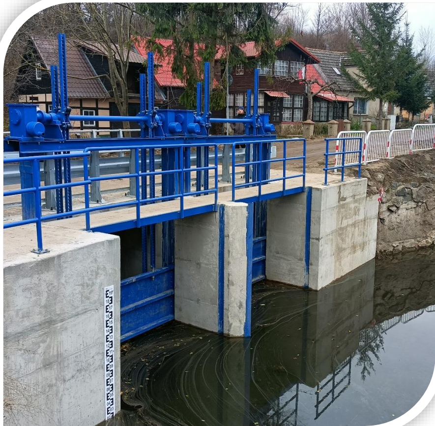
Jaz ze stalowymi zasuwami na rzece Gulczanka (RZGW Bydgoszcz), Fot. W. Warowna
