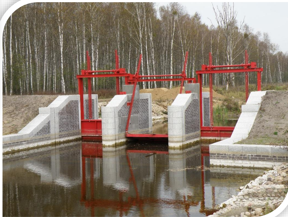
Jaz klapowo-zasuwowy na Kanale Woźnawiejskim (zlewnia Biebrzy), Fot. Z. Kowalewski
