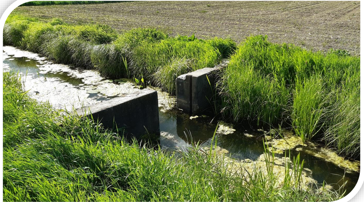
Zastawka szandorowa na rowie melioracyjnym - obiekt nawodnień podsiąkowych Troszyn, Fot. B. Kierasiński
