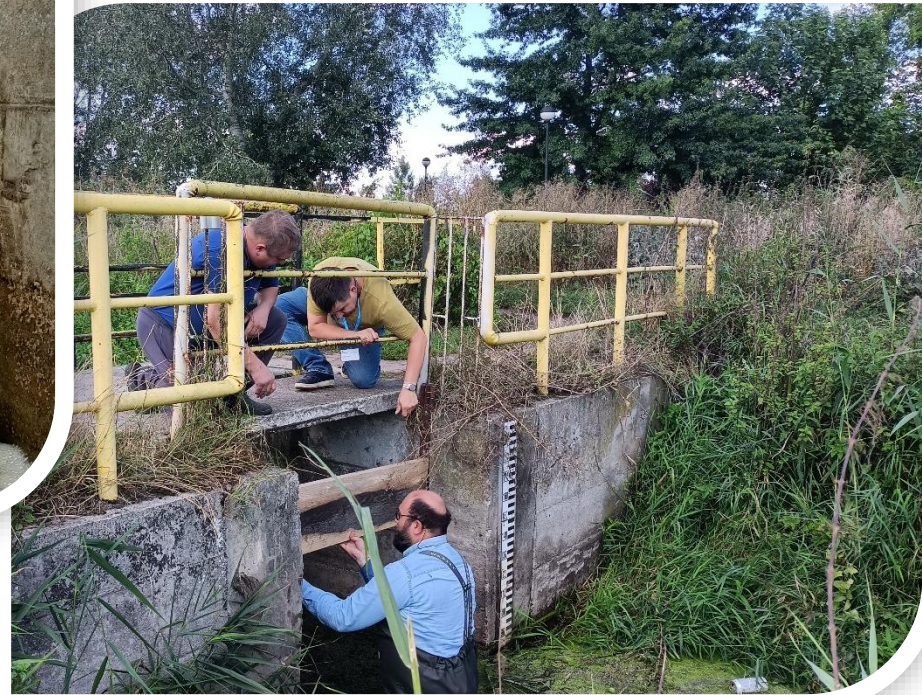
Montaż szandorów na jazy - rzeka Raszynka, Fot. W. Warowna
