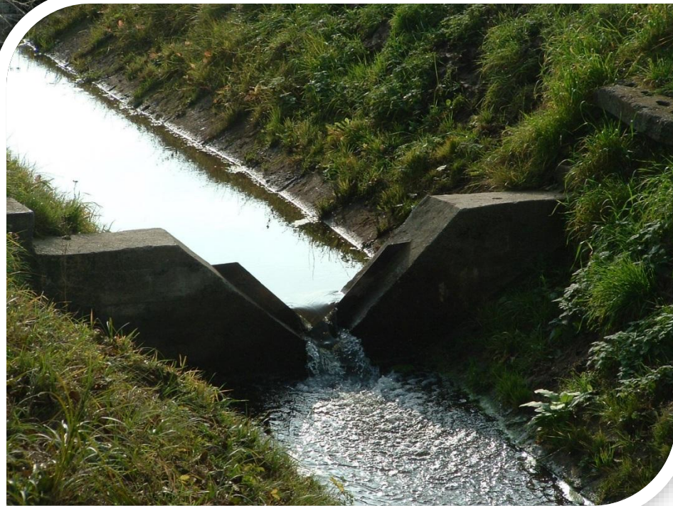
Zastawka betonowa z przelewem trójkątnym, Fot. W. Mioduszewski
