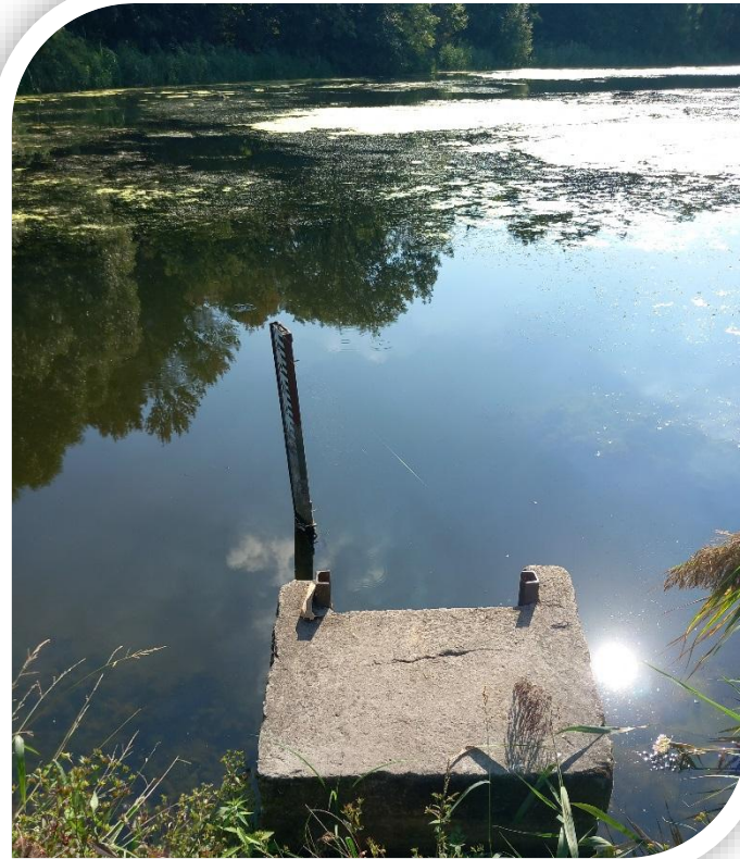
Mnichy spustowe ze stawów w rezerwacie Stawy Raszyńskie Fot. B. Kierasiński
