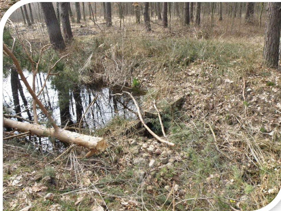
Zastawki drewniane tworzące tzw. małą retencję leśną, Fot. B. Kierasiński
