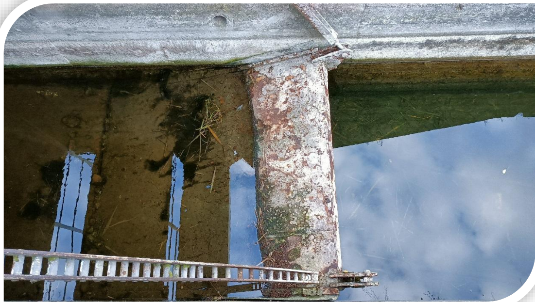
Zastawka z zamknięciem klapowym na doprowadzalniku wody z Kanalu Kuwaskiego, Fot. W. Warowna
