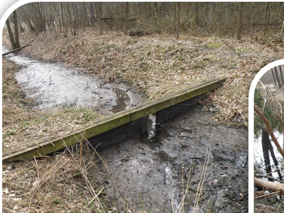
Zastawki drewniane tworzące tzw. małą retencję leśną, Fot. B. Kierasiński
