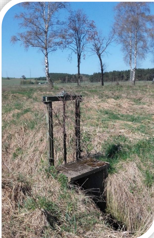
Zniszczona zastawka na obiekcie melioracyjnym, Fot. B. Kierasński
