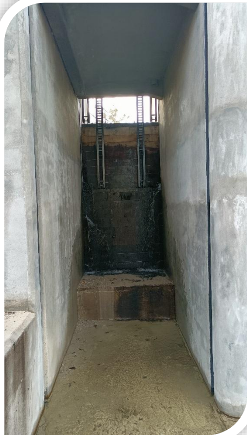
Zasuwy dwudzielne drewniane, Fot. W. Warowna
