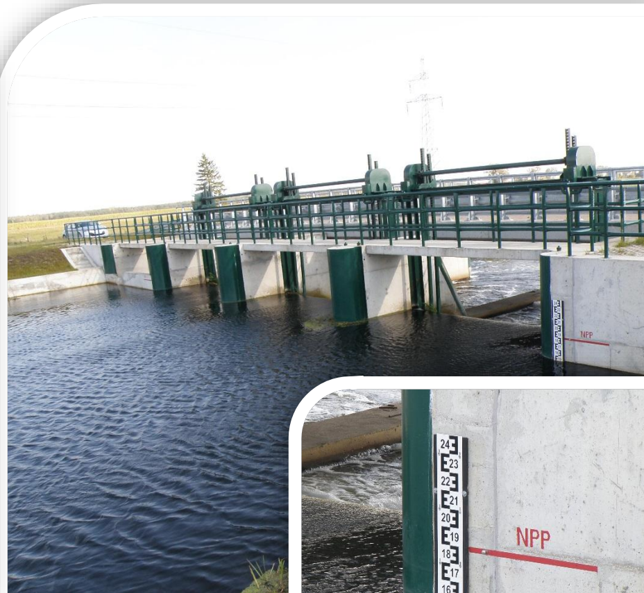
Jaz ze stalowymi zasuwami w zlewni rzeki Narew, Fot. W. Mioduszewski
