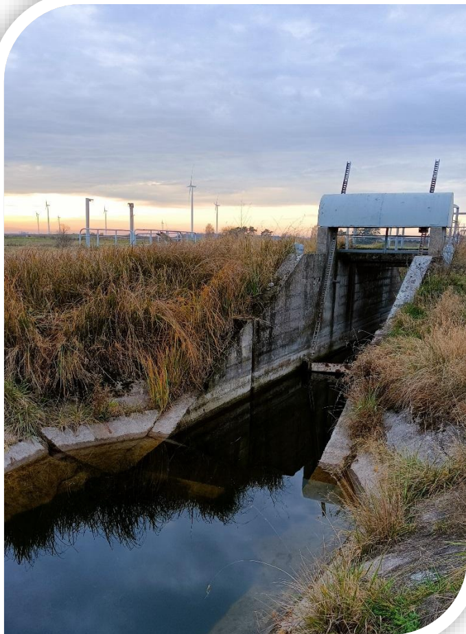
Zastawka z zamknięciem klapowym na doprowadzalniku wody z Kanalu Kuwaskiego, Fot. W. Warowna
