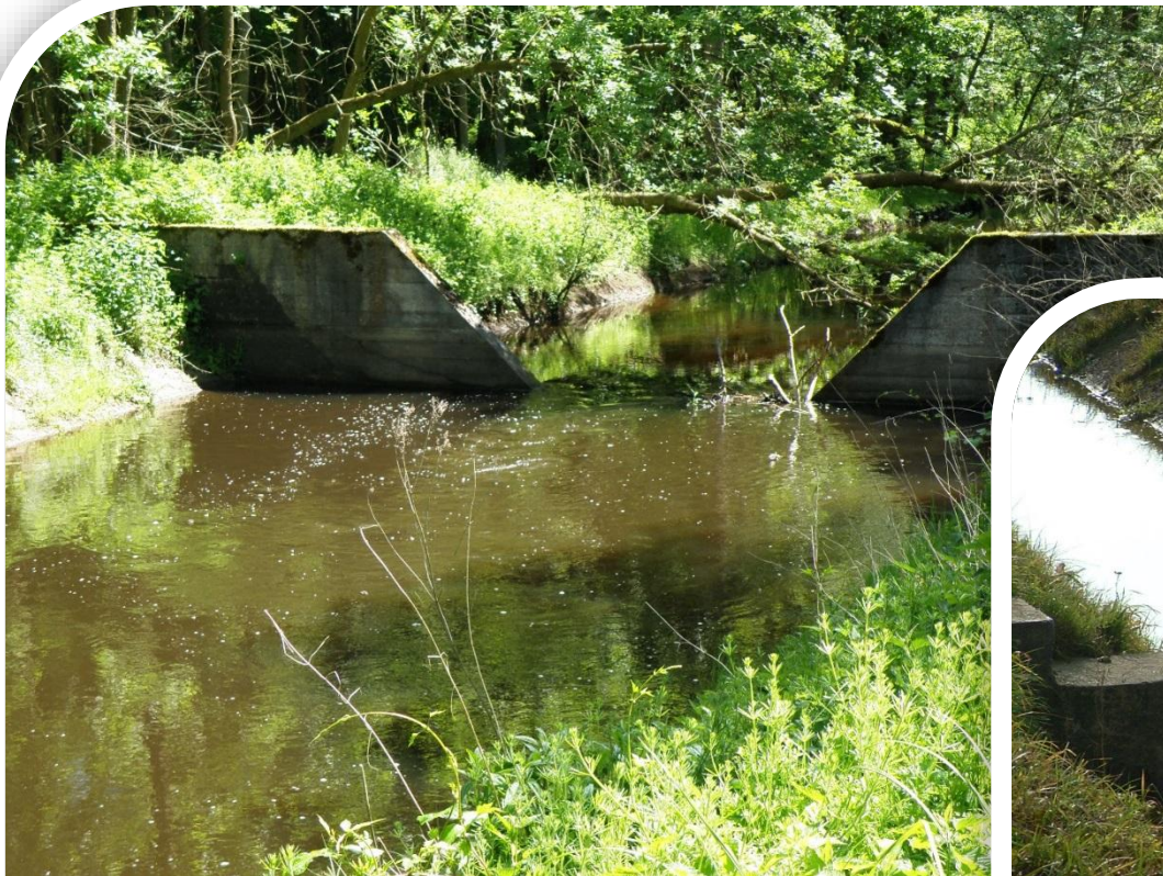
Zastawka betonowa z przelewem trapezowym – kanał w Kampinoskim Parku Narodowym, Fot. Z. Kowalewski
