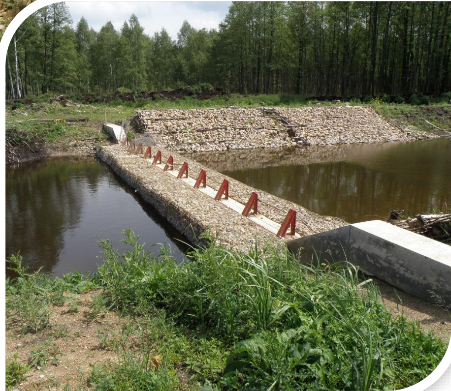
Próg gabionowy na Kanale Woźnawiejskim, Fot. Z. Kowalewski
