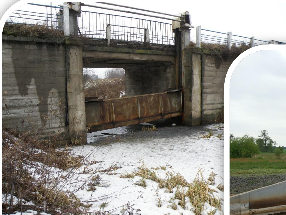
Jaz z unieruchomioną stalową zasuwą na Kanale Kromnowskim w Kampinoskim Parku Narodowym, Fot. W. Mioduszewski
