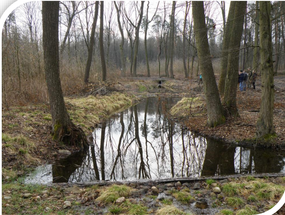
Próg kamienno-drewniany tworzący tzw. małą retencję leśną, Fot. B. Kierasinski
